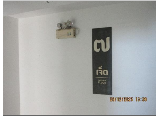
รูปที่ 37 (ต่อ) ไฟส่องสว่างฉุกเฉิน
