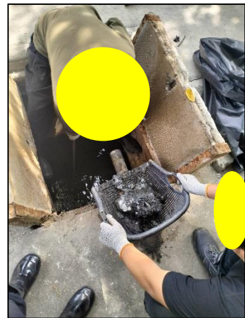
รูปที่ 72 บ่อดักขยะก่อนปล่อยระบายน้ำลงท่อระบายน้ำสาธารณะ
