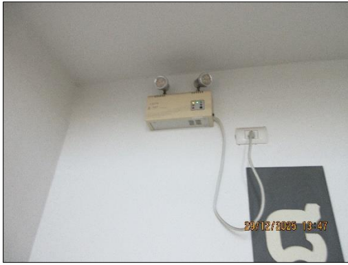
รูปที่ 37 (ต่อ) ไฟส่องสว่างฉุกเฉิน
