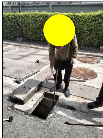
รูปที่ 72 บ่อดักขยะก่อนปล่อยระบายน้ำลงท่อระบายน้ำสาธารณะ
