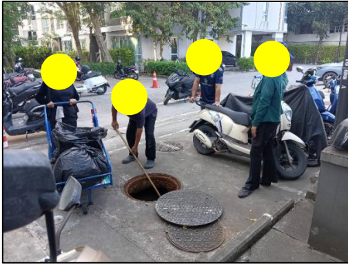
รูปที่ 87 การขุดลอกเศษตะกอนในบ่อพักน้ำ
